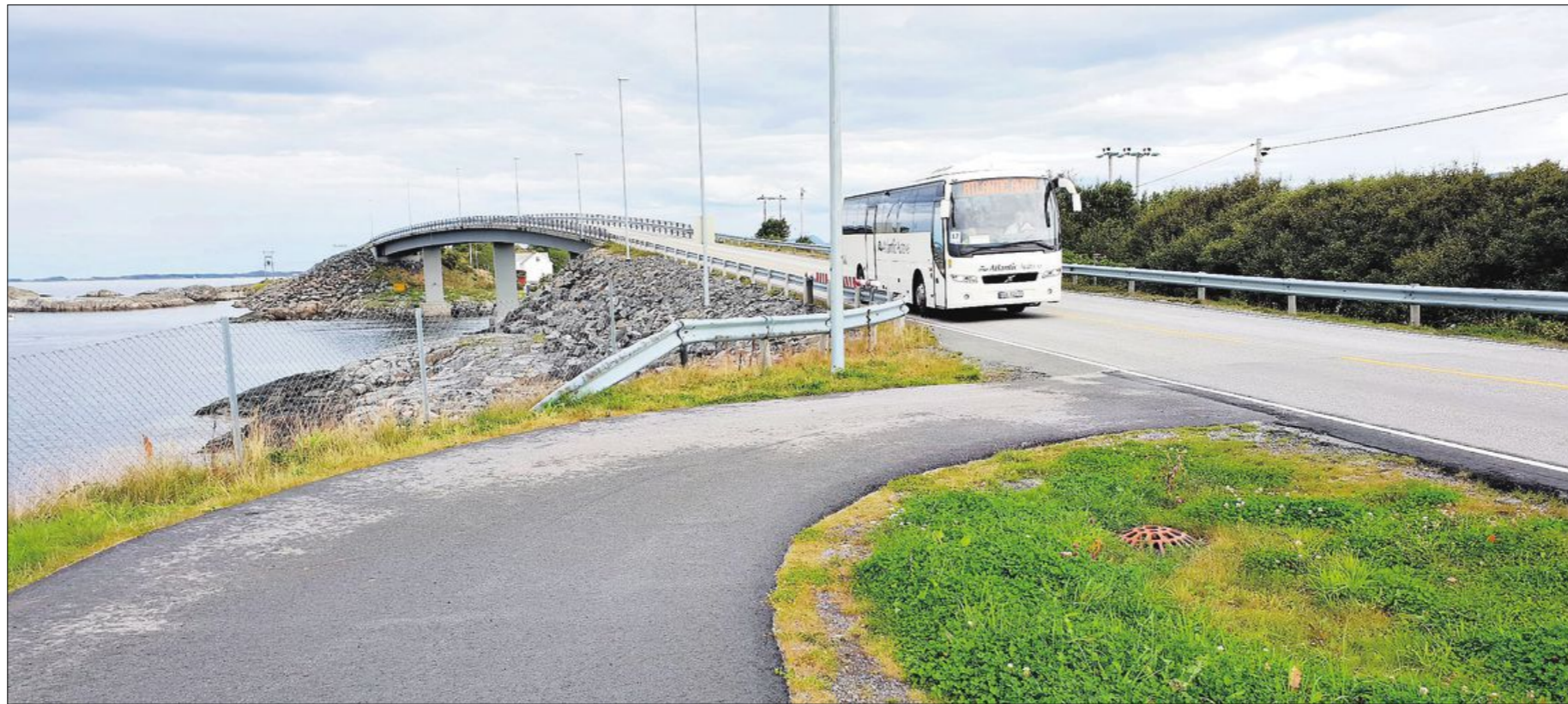
ATLANTERHAVSVEIEN: Hit, men ikke lenger. Sykkelveien stopper ved Skarvøya.
