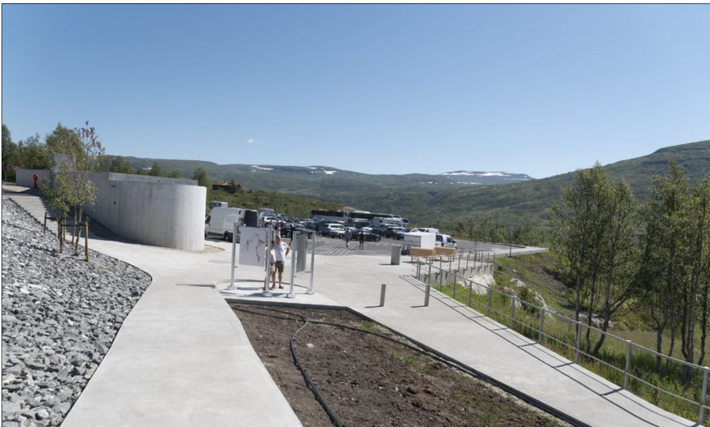
NYTT: Offisiell opning for fyrste byggjestege av turistvegsatsinga ved Vøringsfossen var 4. juli i år. Her ser ein nytt toalettanlegg og parkeringsplass. Teljarar registrerer besøkjande.
