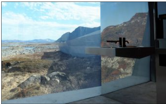
DOUTSIKT: Noe av det mest spektakulære med toalettbygget til Nasjonal turistvei , er utsikten fra toalettskåla. FOTO: CAROLINE STØVRING/MORFEUS AS ARKITEKTER
