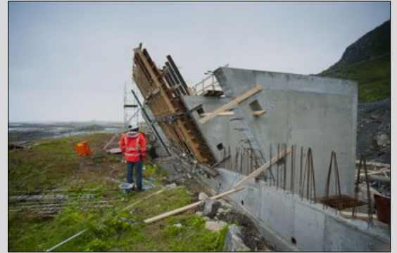
UTFORDRENDE: – Det er faglig utfordrende, for det er nesten ikke en rett vinkel, sa anleggsleder Ivar Kleven, da Andøyposten besøkte byggeplassen i slutten av juni i fjor. FOTO: TONY GULLA SIVERTSEN
