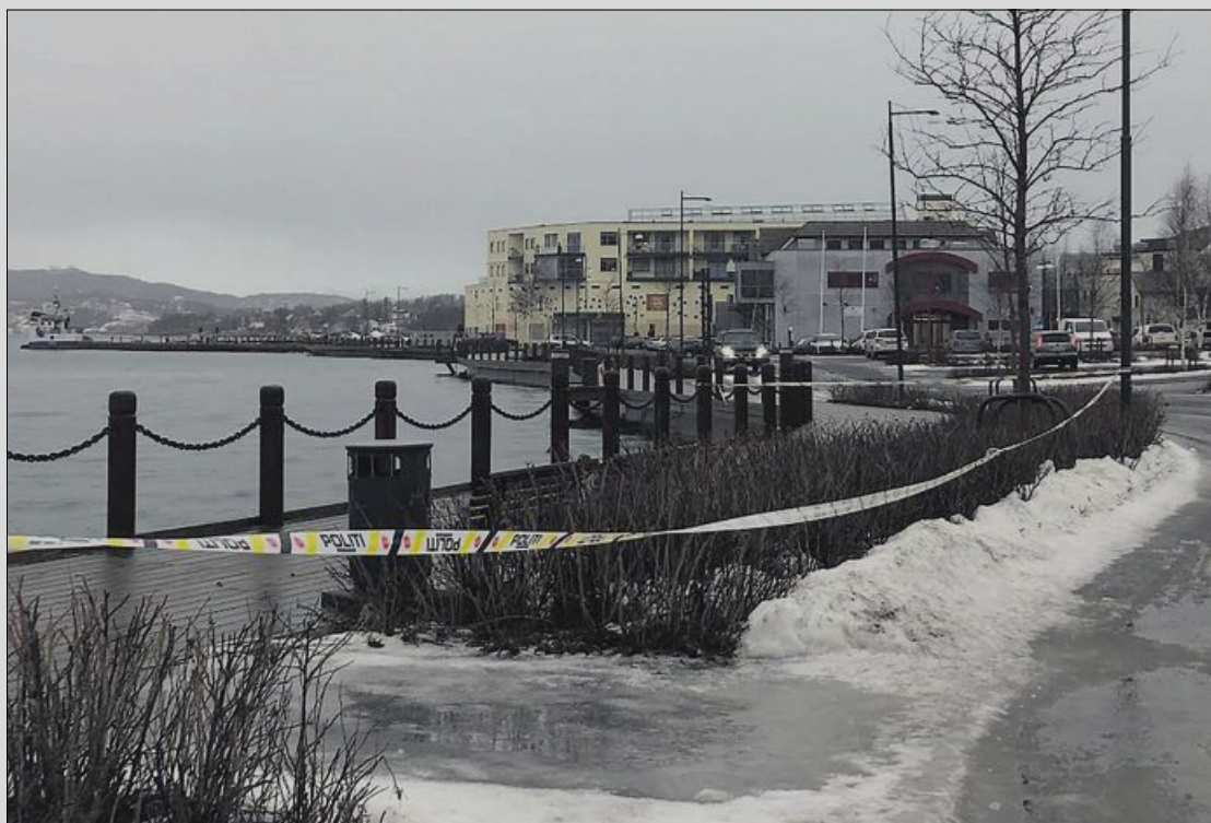
SKADET: Strandpromenaden i Fauske sentrum, og brygga, fikk hard medfart under de to stormene tidligere i år.
